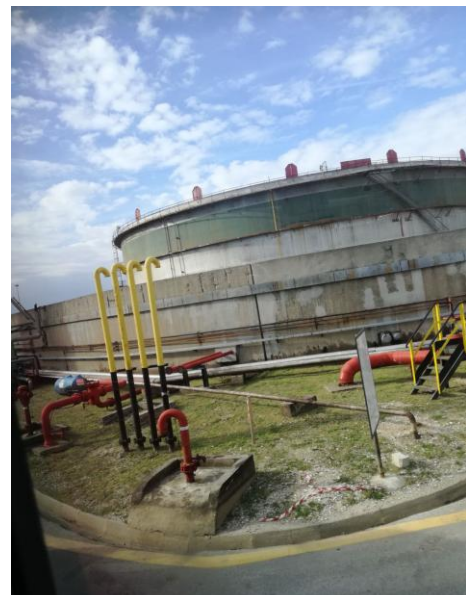
Serbatoi di stoccaggio per il greggio
