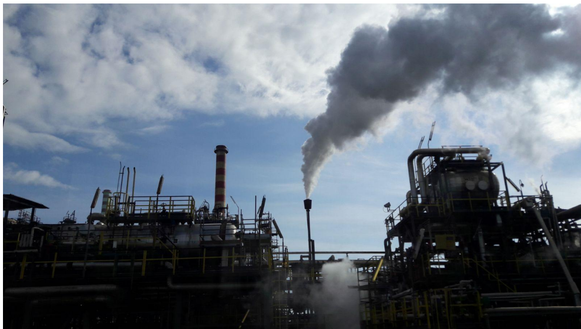
Impianto di idrodesolforazione
